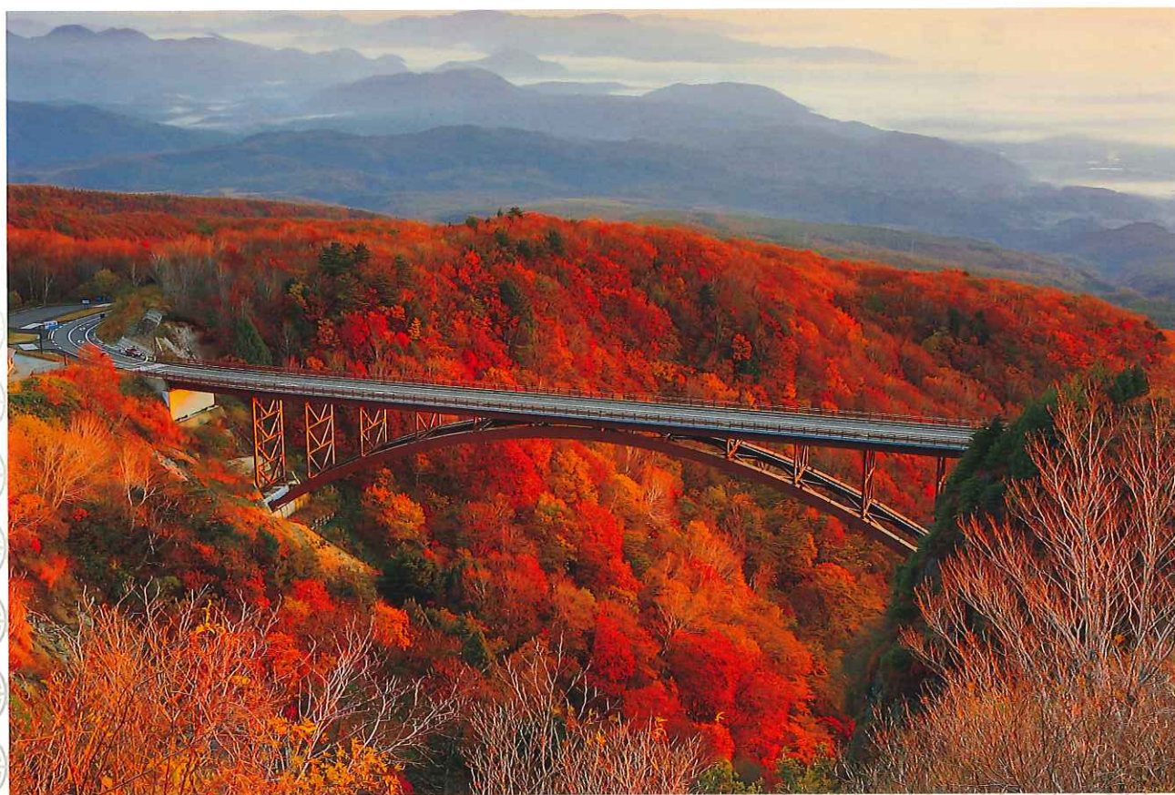
磐梯吾妻スカイラインのつばくろ谷(不動沢橋)
