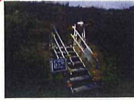
人感センサー付きライト設置例（職場のあんぜんサイトより）
