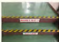
段差に注意喚起をした例 「職場のあんぜんサイト」あんぜんプロジェクトから抜粋
